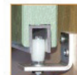
Guidage bas fixé en façade
